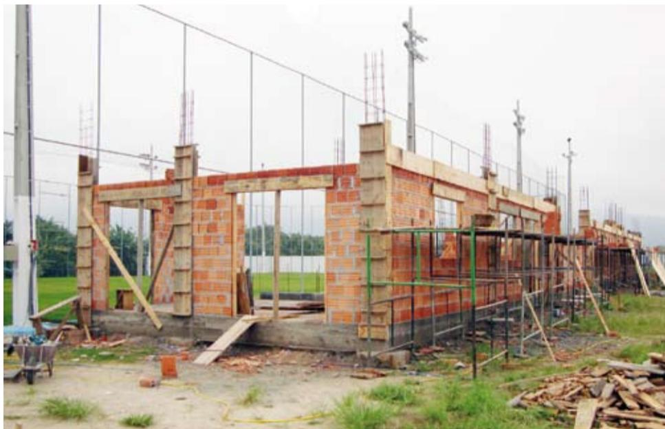
**A**s obras de construção da arquibancada do Complexo Esportivo, estão concentradas no levantamento das paredes, devendo a próxima etapa ser o assentamento da laje.
